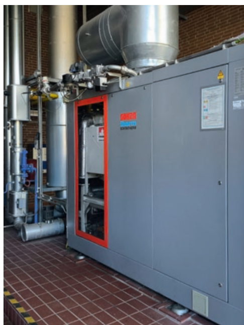
Blockheizkraftwerk
